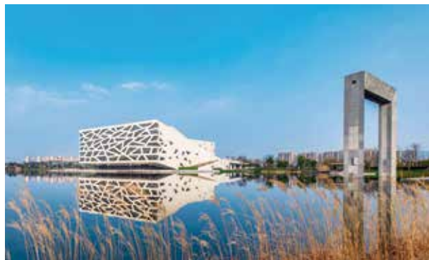
临平大剧院 Linping Grand Theater
